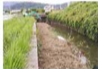
八幡川の河川除草工事による水害の解消
