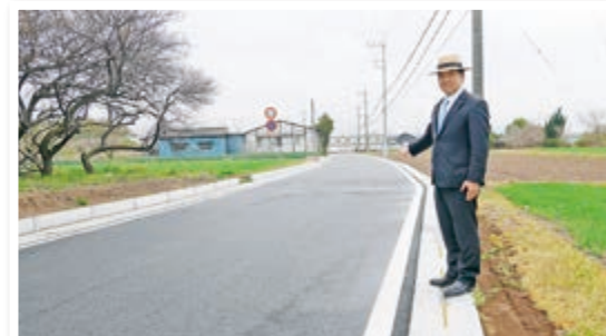
改修された道路にて
